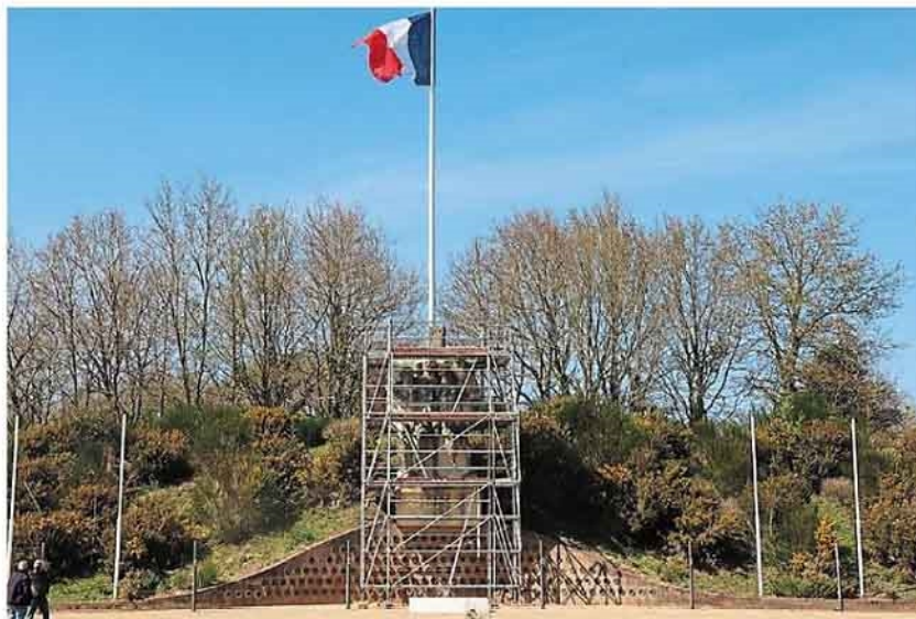
Le Mémorial de la Carrière des fusillés, au lieu-dit la Sablière à Châteaubriant, fait l'objet d'un travail de restauration.
